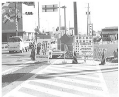
▲国道1号小向交差点
