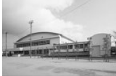
小学校体育館・プール完成 (平成27年)
