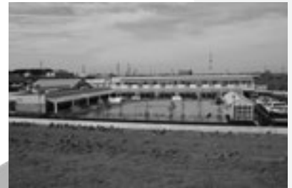
幼保一体施設「あさひ園」完成 (平成21年)
