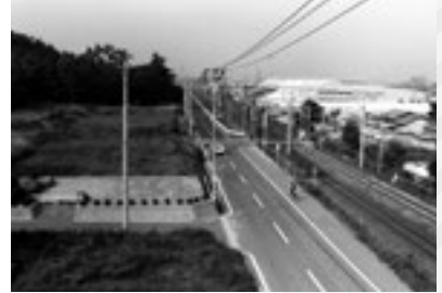
県道蒔田朝日線改良工事完成 (昭和55年)
