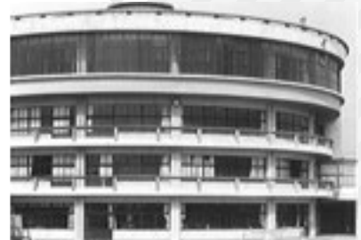
小学校円形校舎完成 (昭和37年)
