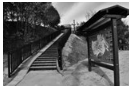
(1月 柿城跡改修工事)
