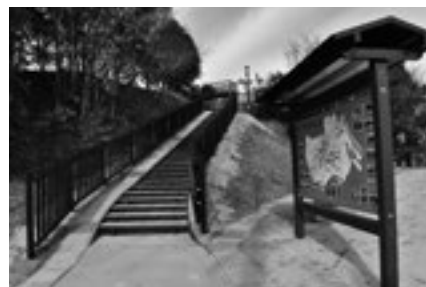
(1月 柿城跡改修工事)
