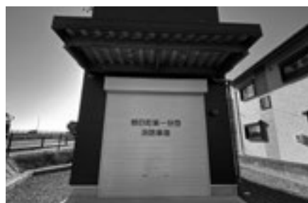
(3月 朝日町消防団第1分団消防車庫の更新)
