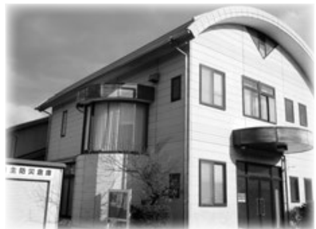
▲補修予定の白梅東集会所分館：上（外壁塗装） 小向分館：下（外壁・非常階段塗装等）
