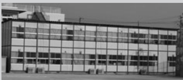
▲継続利用する仮設校舎
