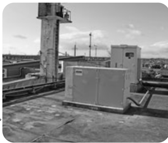
▲役場庁舎の屋上
