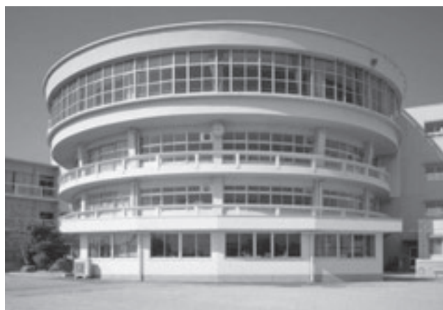
平成22年8月職員室増築
