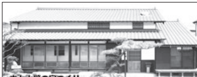
木と土壁の家づくり
