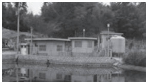
柿水源地工事完了 (昭和42年)
