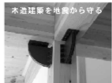
耐震補強装置 仕ロダンパー
