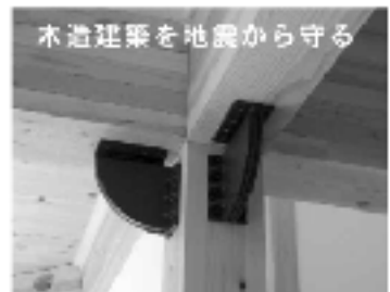
耐震補強装置 仕口ダンパー
