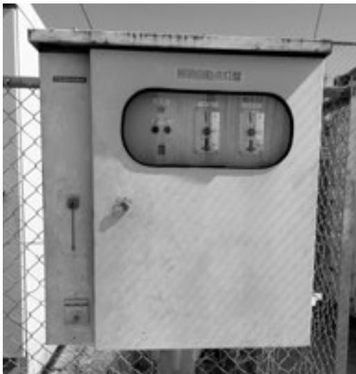
▲更新するスポーツ施設自動点灯盤
