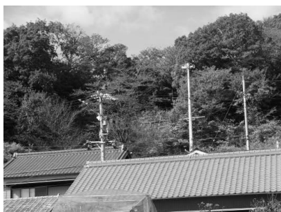
東海豪雨時崖崩れ箇所
