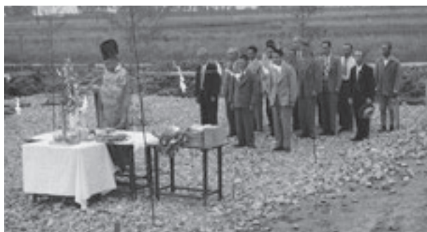
小学校プール起工式（昭和31年6月1日）
