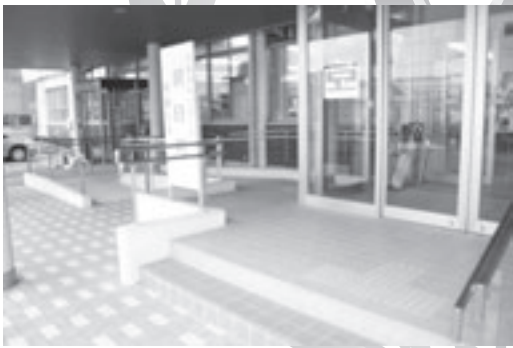
役場玄関バリアフリー化 (平成18年)
