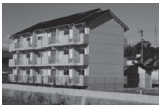
町営住宅（埋縄団地）完成（平成9年）
