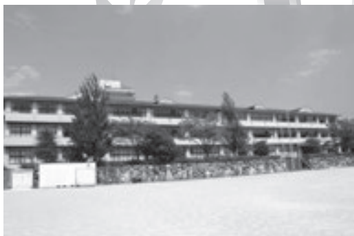
朝日中学校が完成 (平成2年)
