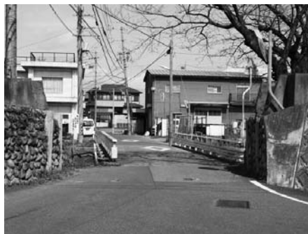
(縄生地区橋本橋及び周辺整備事業)
