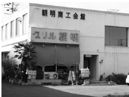
(建て替えを行う朝明商工会館への建設補助)
