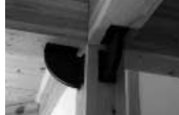
耐震補強装置 仕口ダンパー
