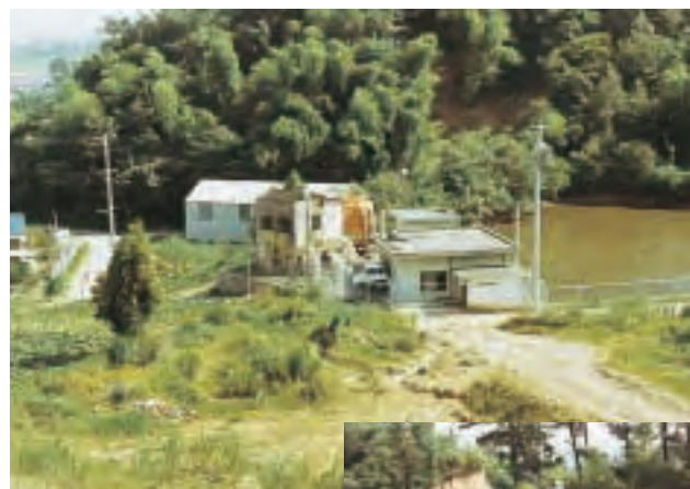
▲柿水源地(昭和42年)
